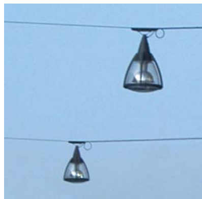
OPENBARE VERLICHTING DOOR ARMATUREN AAN SPANDRADEN TUSSEN DE GEVELS
