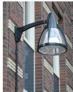
ARMATUUR OP UITLEGGERS AAN DE GEVEL
