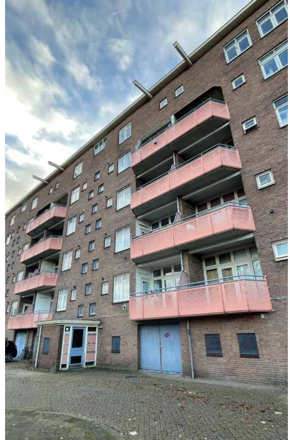
noordoost-zijde huidige complex Waalstraat
