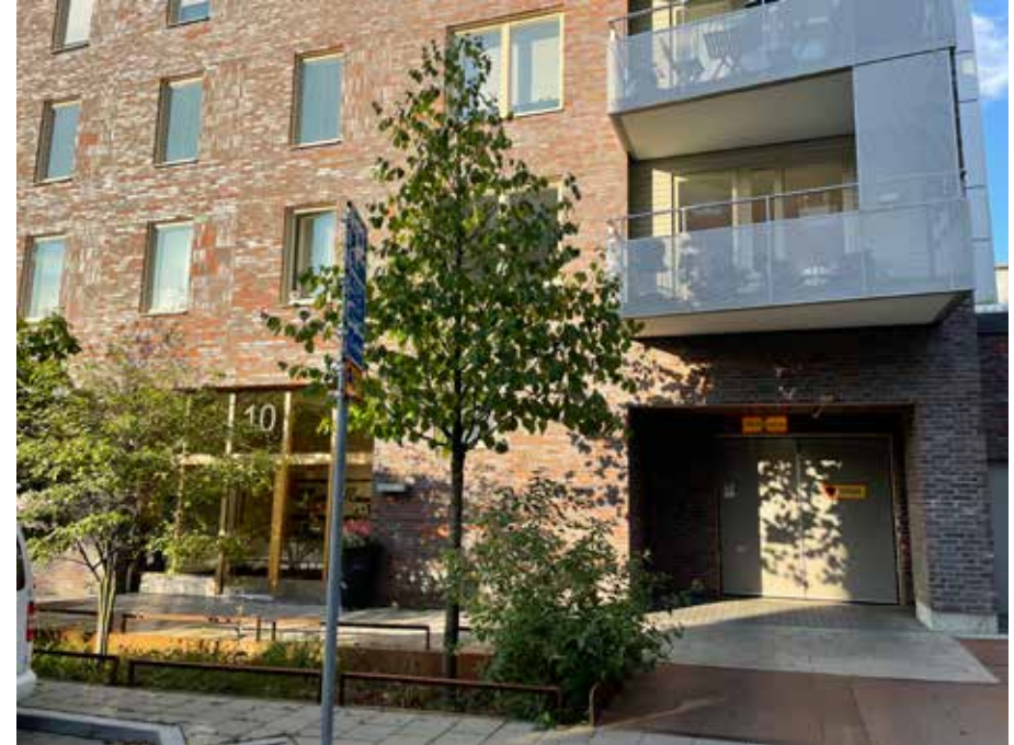
parkeerentree ondergeschikt in gevelbeeld
