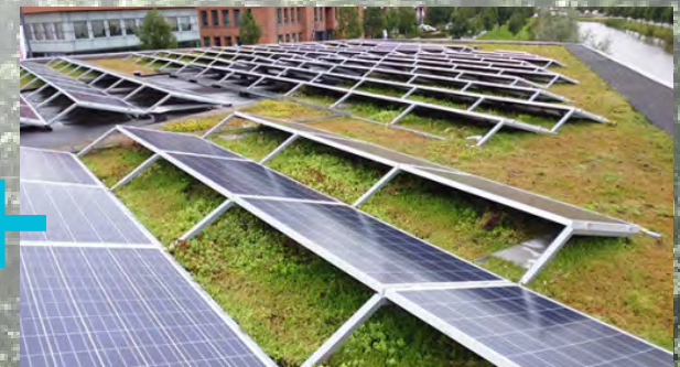
...en groen & energie op daken
