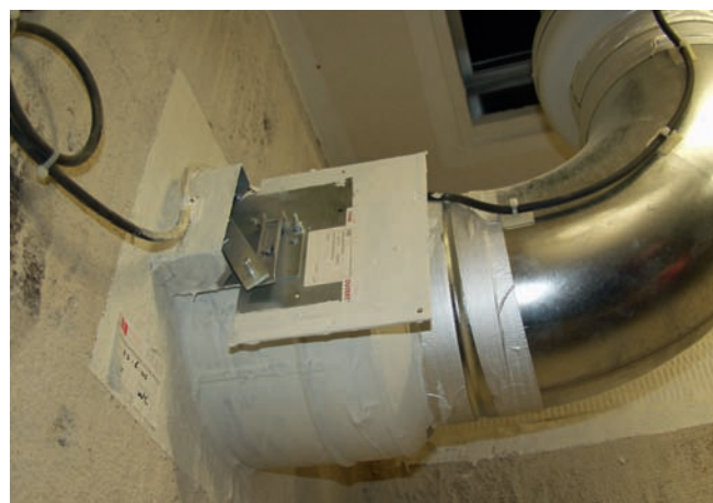
Brandklep op juiste wijze aangebracht
