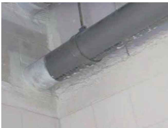
Toepassing van endotherme kit is geen optie. Hier moet een brandmanchet toegepast worden
