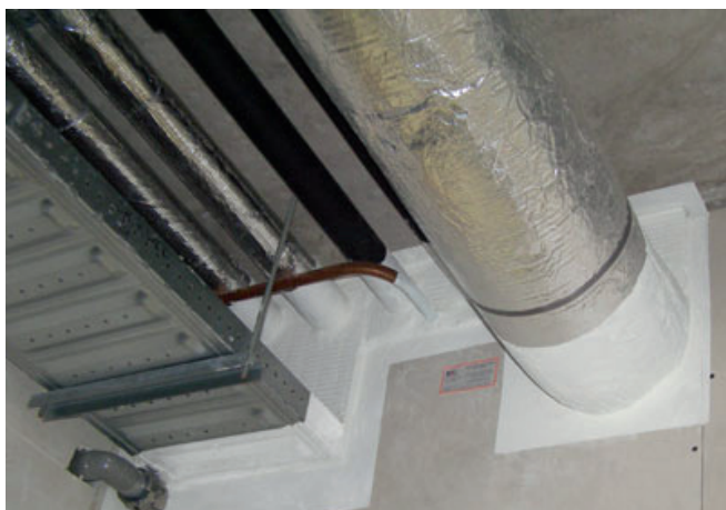
Goede afdichting van kabels en leidingen
