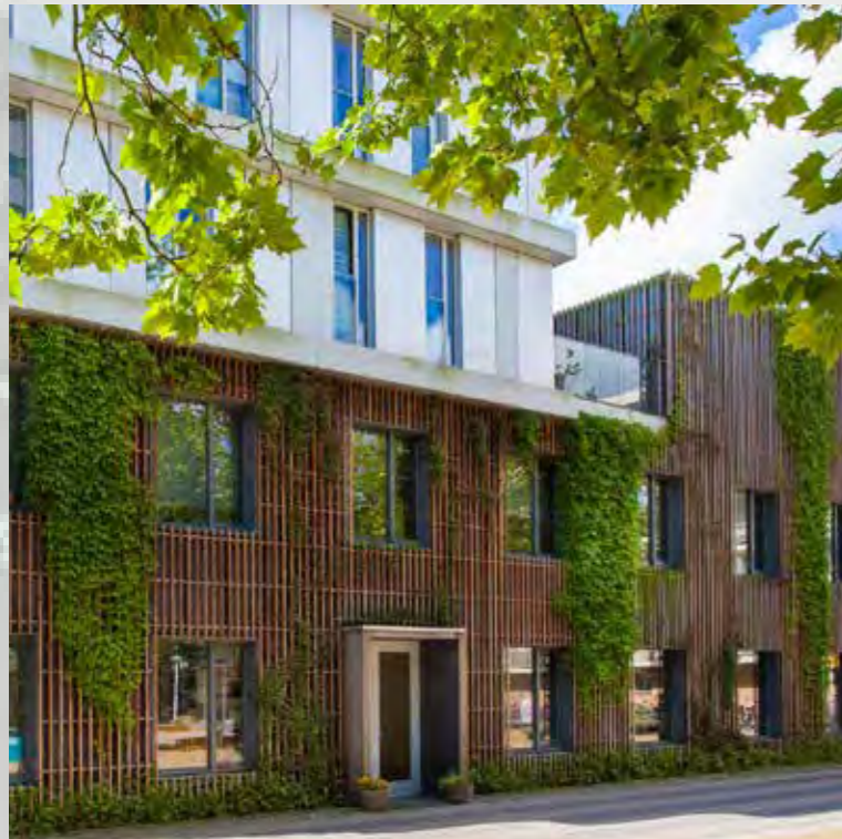
begroeiing vanaf maaiveld, niet uit bakken. De gevel ziet er zonder groen ook verzorgd uit.
