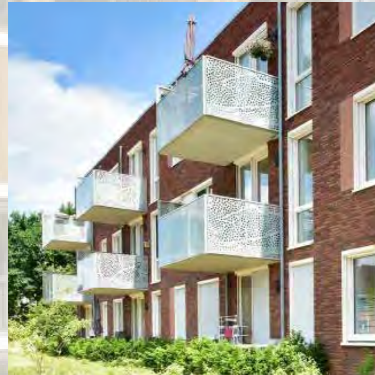
balkons zijn ontworpen in relatie met de architectuur, zorg voor privacy door goed gekozen hekken
