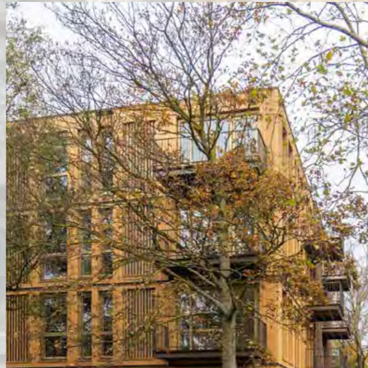
De dakrand loopt rondom het gebouw door (en een terugliggende verdieping ligt daar achter)
