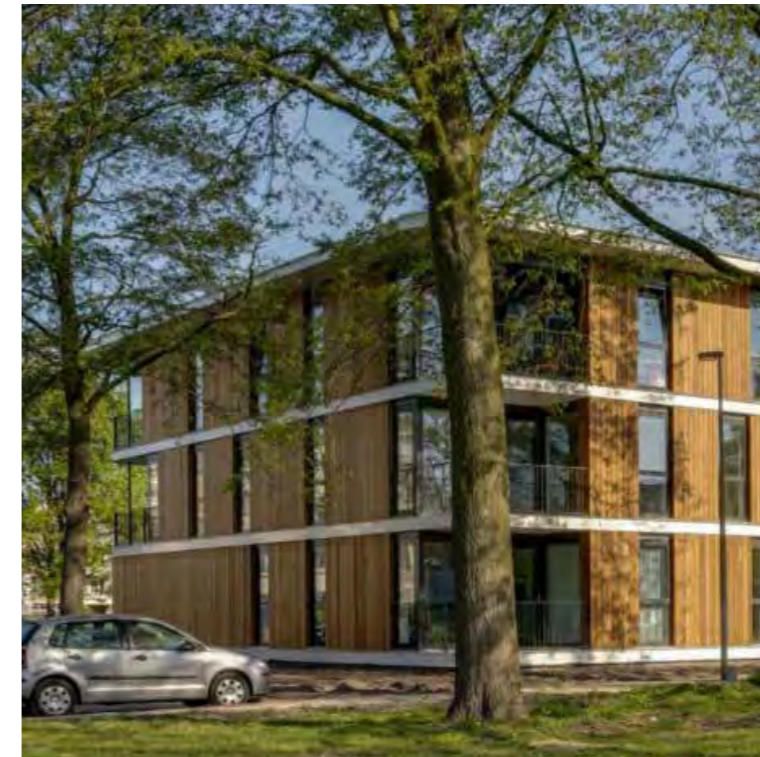
natuurlijke materialen met een passende detaillering (bij hout past bijvoorbeeld een robuust dakoverstek)
