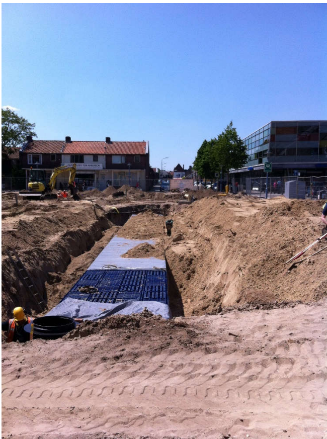
Figuur 6-1 Aanleg Q-bics (waterberging) voor entree gemeentehuis
