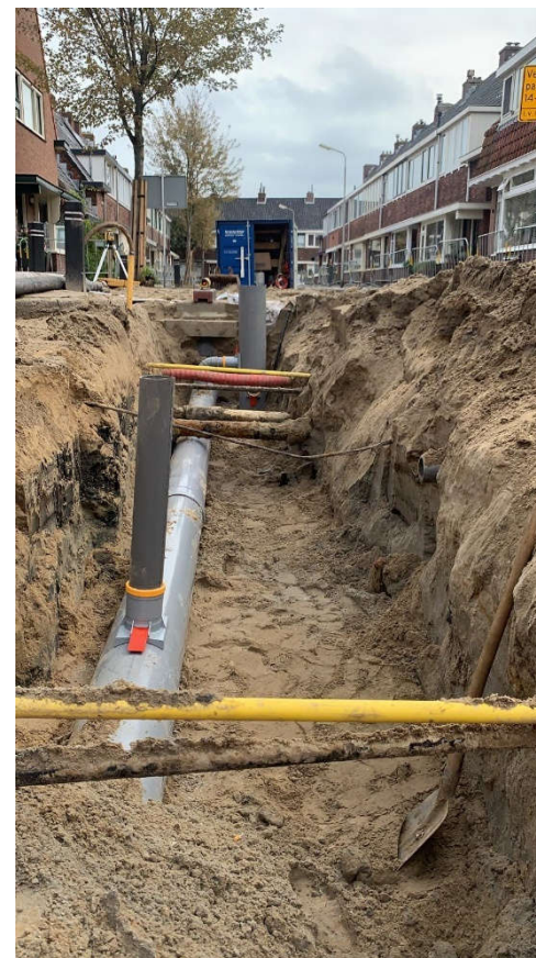
Figuur 5-1 Hemelwaterafvoer (HWA) Watervlietstraat
