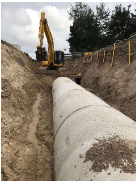
Figuur 5-2 Aanleg riolering bedrijventerrein Grot
