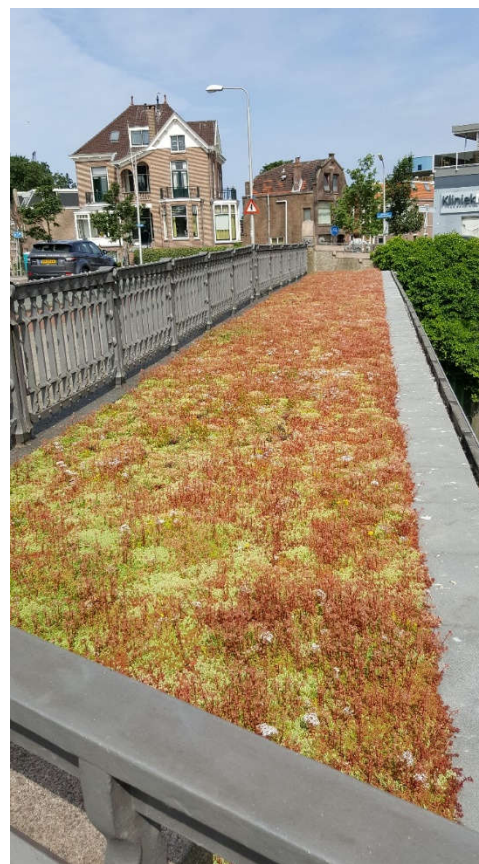
Figuur 6-4 Julianabrug met sedum voor waterberging.
