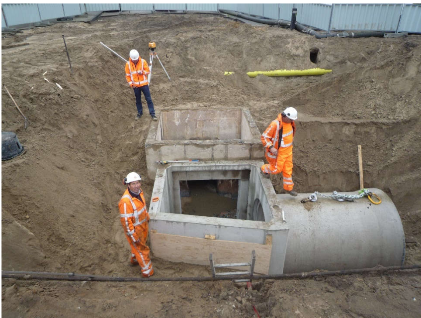
Figuur 7-2 Aanleg inspectieput Ijmuidersstraatweg
