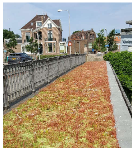
Figuur 1-1 Één van de stappen in duurzaamheid: groen sedumdak Julianabrug. Goed voor wateropvang, koelte en biodiversiteit.
