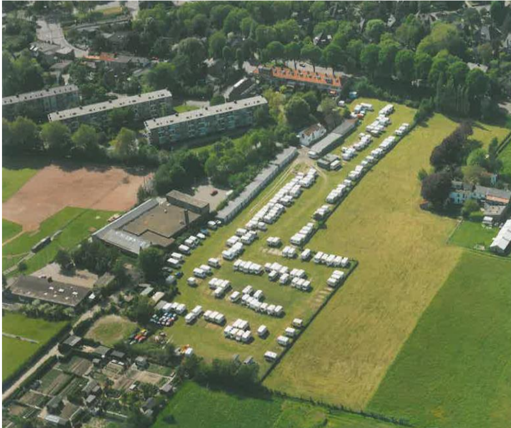
Figuur 6: Oude situatie met caravanstalling en bedrijfsbebouwing
