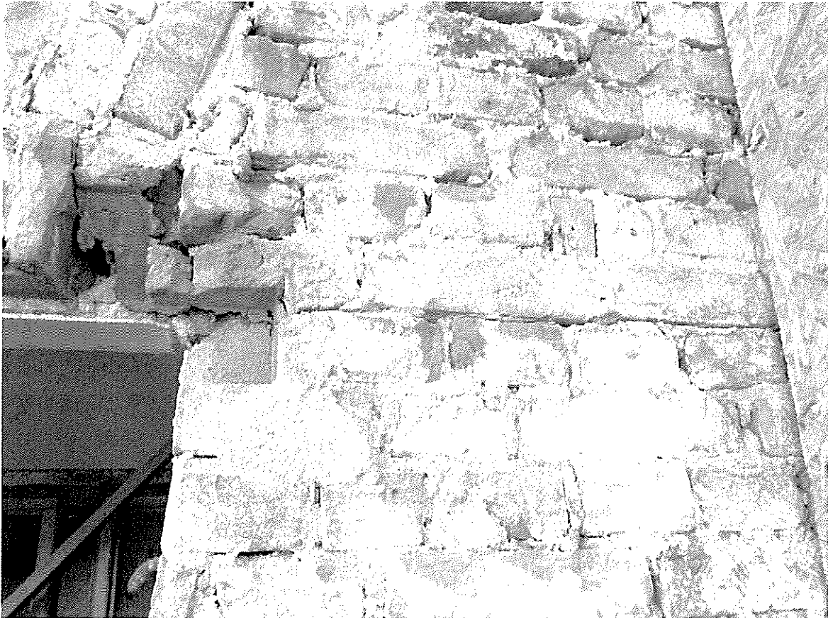
Foto 9 horizontale scheur in penant bij JL9 loopt door naar JL10 zie foto 10
