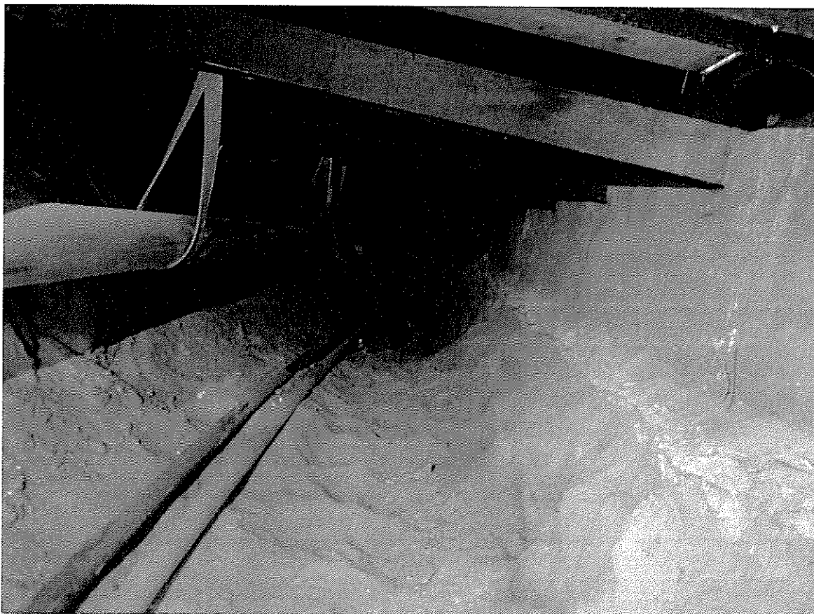
Foto 2 Ontgaving naast bouwmuur JL8 en JL9 aan zijde JL9
