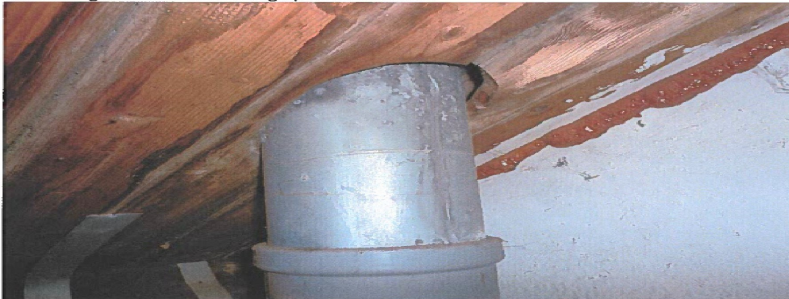
Kieren en gaten in de aansluiting op de bouwmuren
