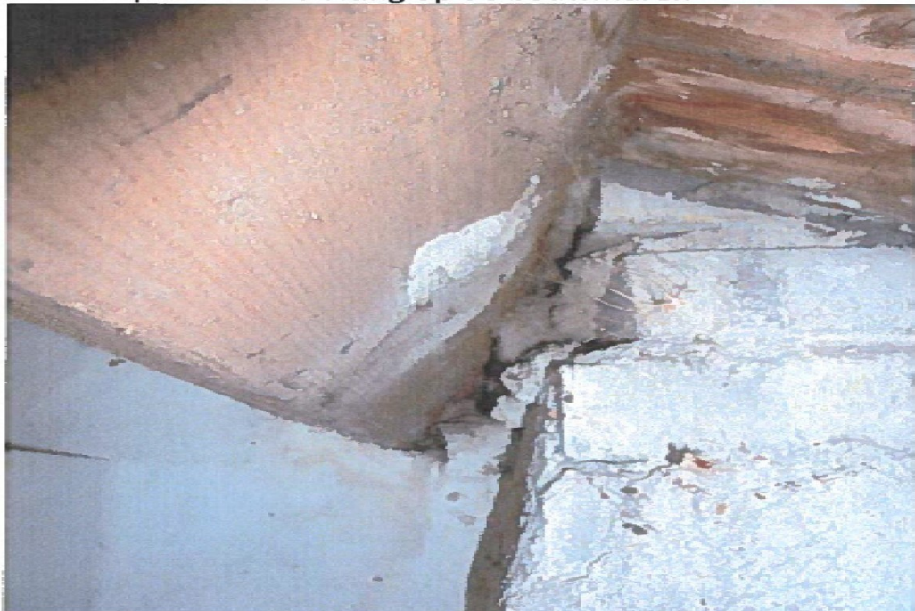
Kieren t.p.v. de aansluiting op de bouwmuren
