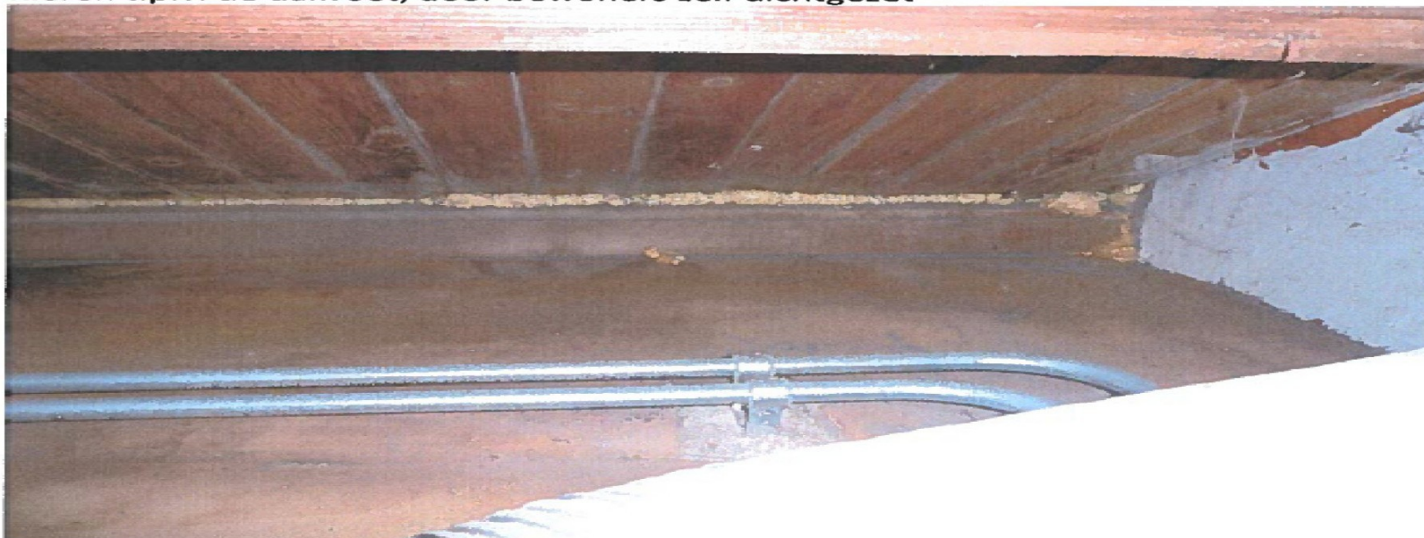
Kieren t.p.v. de dakvoet, door bewoners zelf dichtgezet
