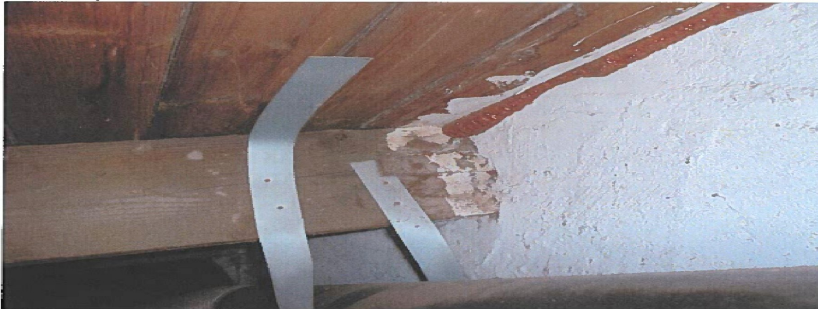
Kieren t.p.v. de dakvoet, door bewoners zelf dichtgezet
