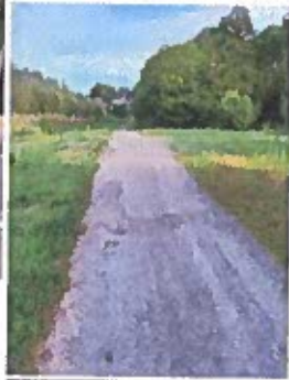
Pad voorzien van verlichting
