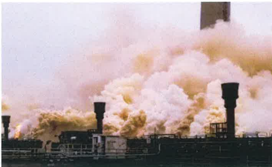
De ruwgas-emissie bij de kooksfabriek 2 op 30.10.2018
